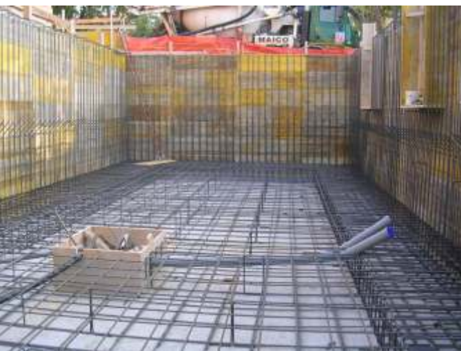
un particolare dei lavori
